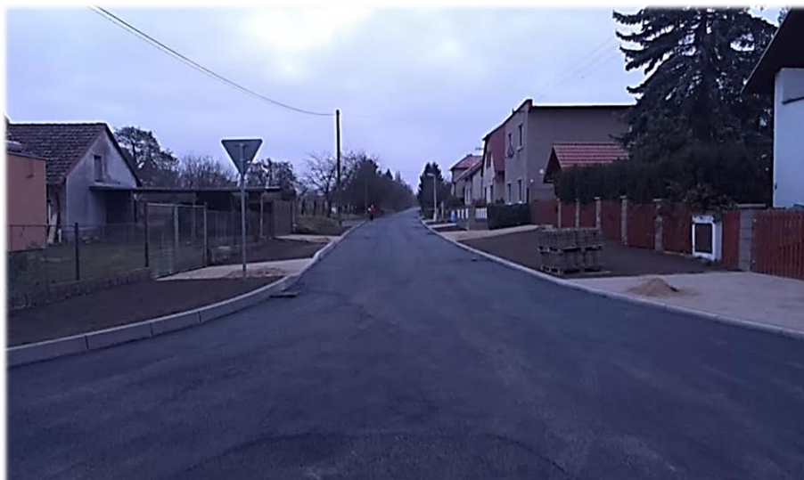
REKONSTRUKCE MÍSTNÍ KOMUNIKACE STS - HABEŠ
